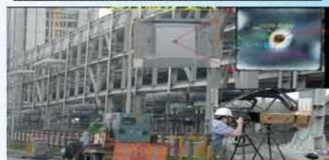
六輕鋼架結構殘餘應力檢測
