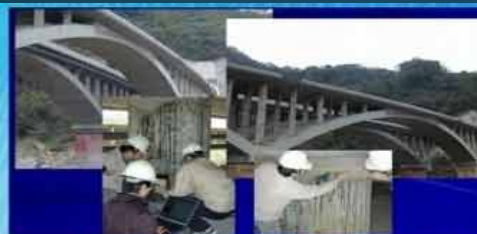
苗栗拱橋橋梁結構損傷檢測
