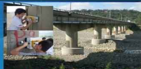
北部(59座)橋墩鋼筋尺寸檢測
