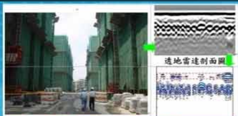
台中建築房屋峰窩/裂縫檢測
