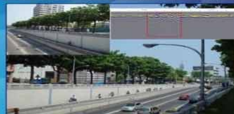
高雄地下道沉陷非破壞檢測
